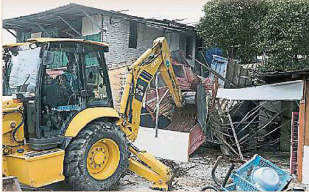
梳邦再也市议会出动神手拆除违例扩建的建筑物。
